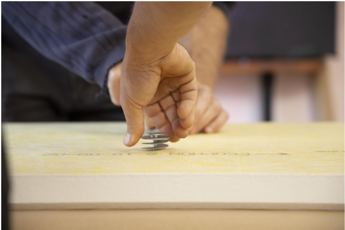
Gyári horgony kézzel történő betekérése hangfogó táblába
