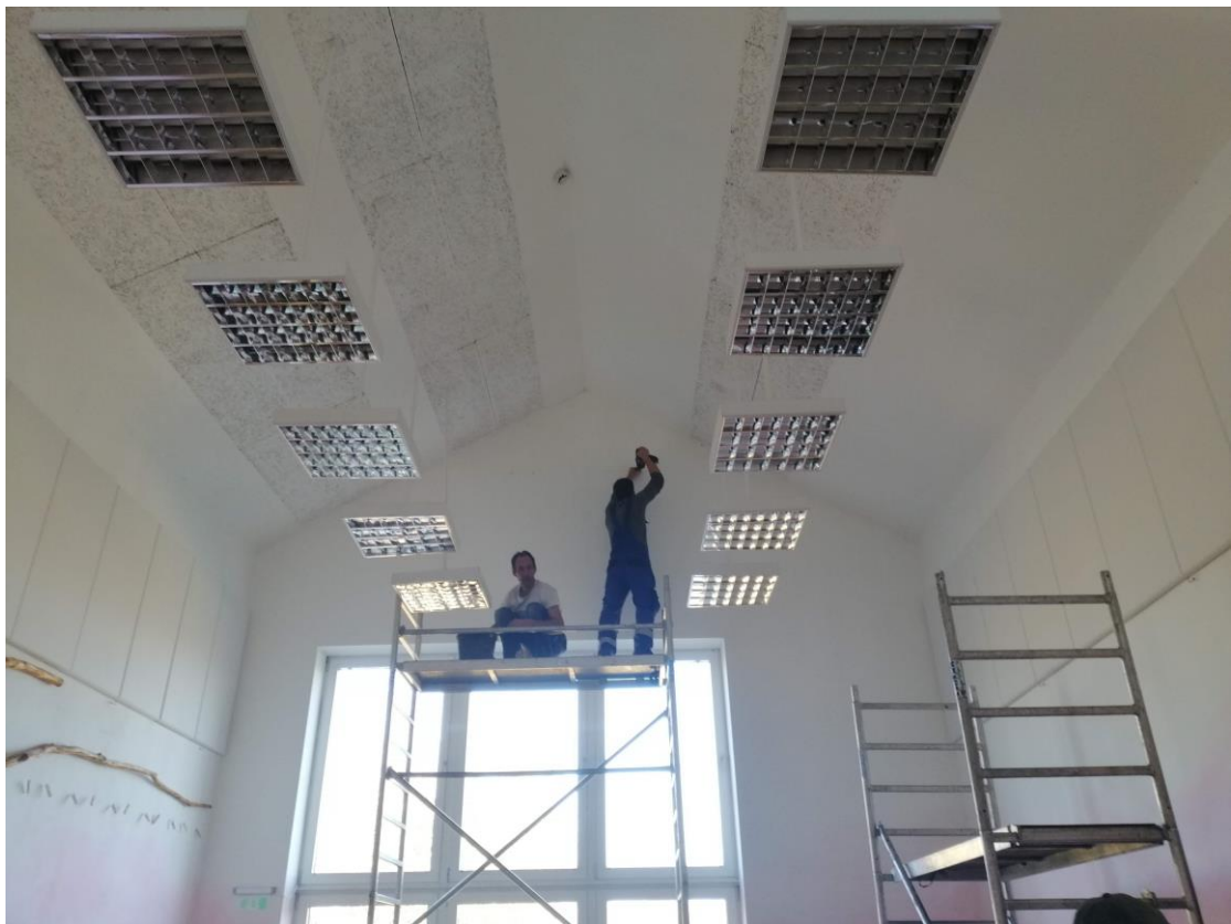
Oromfal (rövid oldal) 1 szinttel magasabb állványról történő munkavégzés
