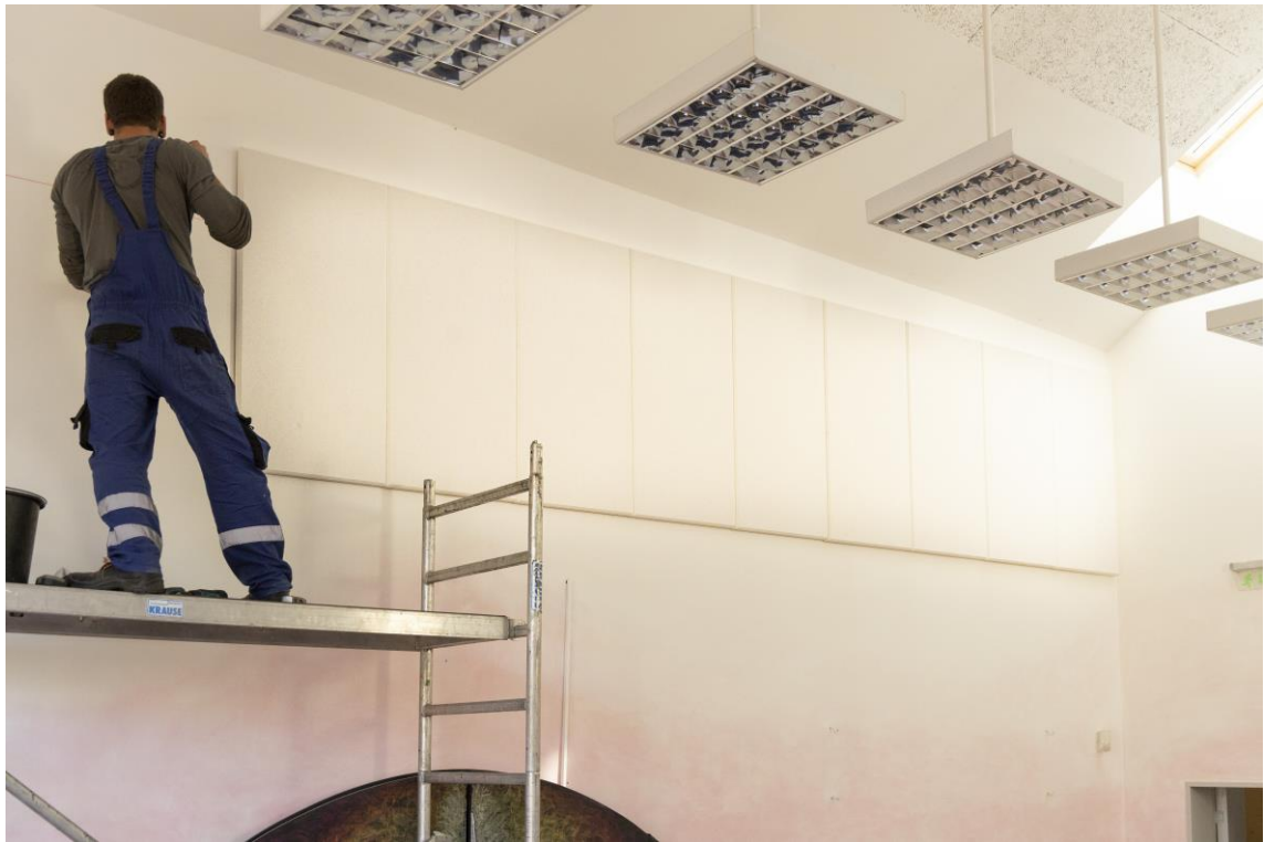
Falban furatok készítése, sínek felfúrása, táblák elhelyezése
