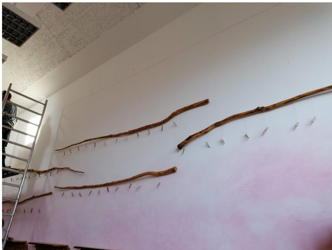
Oldalfalon hangfogó elhelyezési síkjának kitűzése
